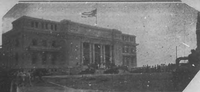
Fachada principal del Palacio de Justicia de Santa Clara, magnífico edificio inaugurado el domingo en esta ciudad
